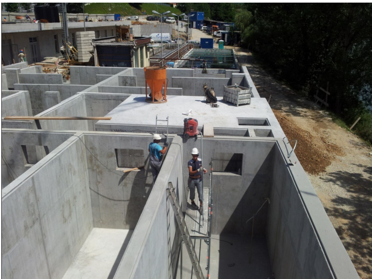
Izgradnja nove MBR ČN Novo mesto
