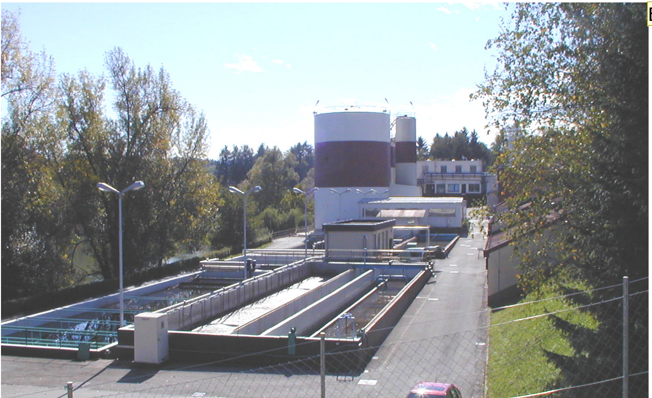
Pogled na staro KČN Novo mosto
